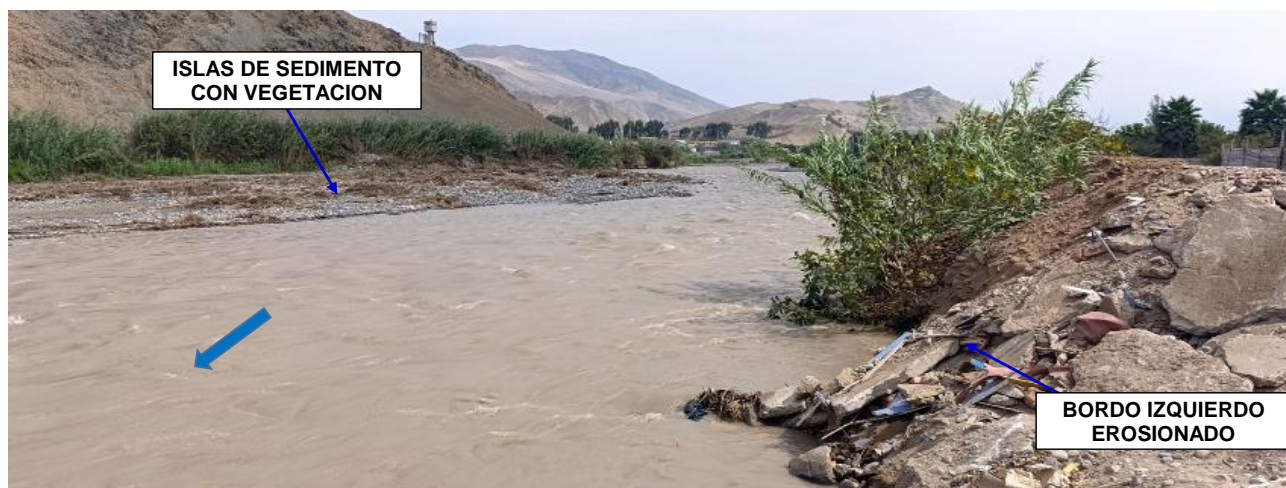
FIGURA N°02: RIO CHANCAY HUARAL, SECTOR MONTECHICO CON EL CAUCE COLMATADO E ISLAS DE FLUJO DE DETRITOS QUE DESVIA EL CAUDAL DEL RIO PRINCIPALMENTE HACIA LA MARGEN IZQUIERDA EROSIONANDO EL DIQUE.
