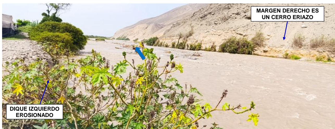
FIGURA N°04: RIO CHANCAY HUARAL, CON EL DIQUE IZQUIERDO CONFORMADO DE MATERIAL PROPIO CON EROSIÓN AVANZADA Y EL CAUCE DEL RIO COLMATADO DE FLUJO DE DETRITOS.
