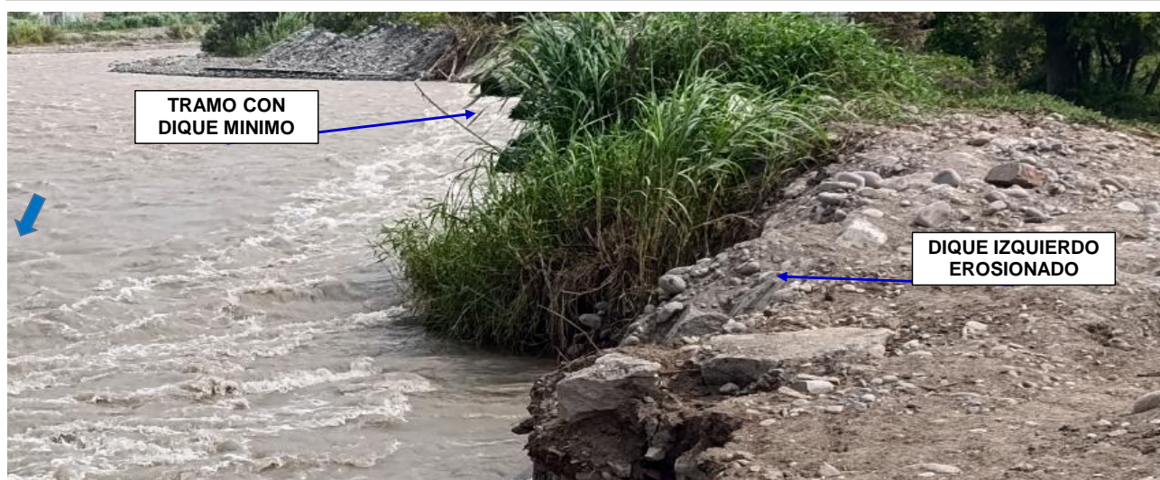
FIGURA N°03: RIO CHANCAY HUARAL, SECTOR MONTECHICO CON EL DIQUE MUY EROSIONADO EXPUESTO A UN DESBORDE ANTE UN INCREMENTO DE CAUDAL QUE AFECTARIA A DIVERSAS ACTIVIDADES, PRINCIPALMENTE A CULTIVOS DE PAN LLEVAR.
