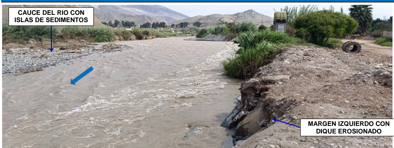
FIGURA N°01: TRAMO CRÍTICO EN EL RÍO CHANCAY HUARAL MARGEN IZQUIERDO, MONTECHICO, CON EL DIQUE CONFORMADO DE MATERIAL PROPIO CON EROSION AVANZADA, EXPUESTO A UN DESBORDE EN DICHA MARGEN DE RÍO.
